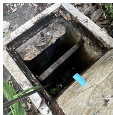
ภาพแสดงการเก็บตัวอย่างน้ำจุดที่ 2 บริเวณบ่อพักน้ำสุดท้าย ของระบบระบายน้ำของโครงการก่อนระบายลงสู่ระบบระบาย น้ำบริเวณด้านหน้าโครงการ
